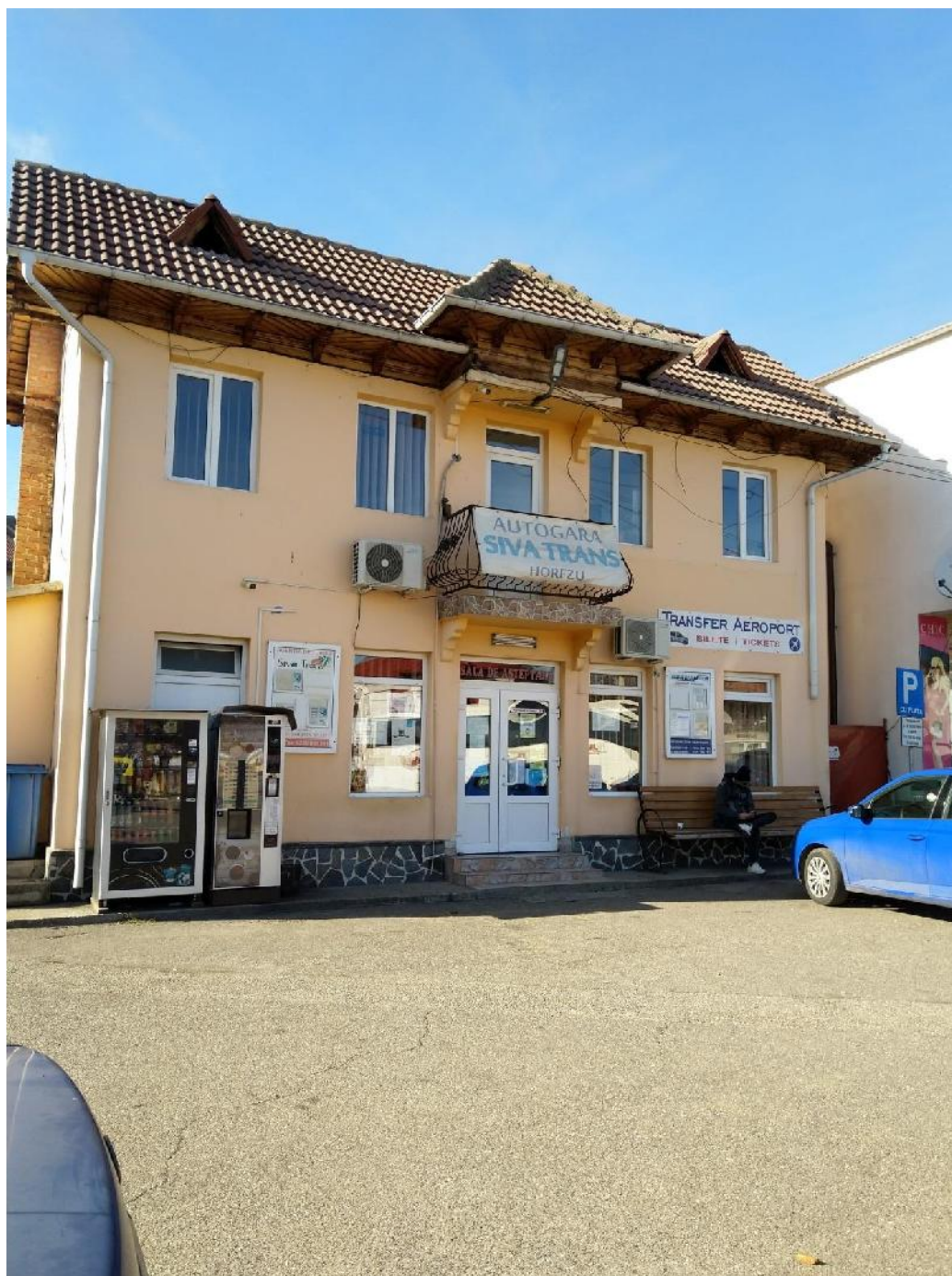
Figura I.2. 22 - Autogara Siva Trans str. Tudor Vladimirescu
